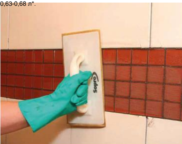
5 змивання поверхні, облицьованої скляною мозаїкою, коли затирочний розчин застигає в міжплиточному шві.
