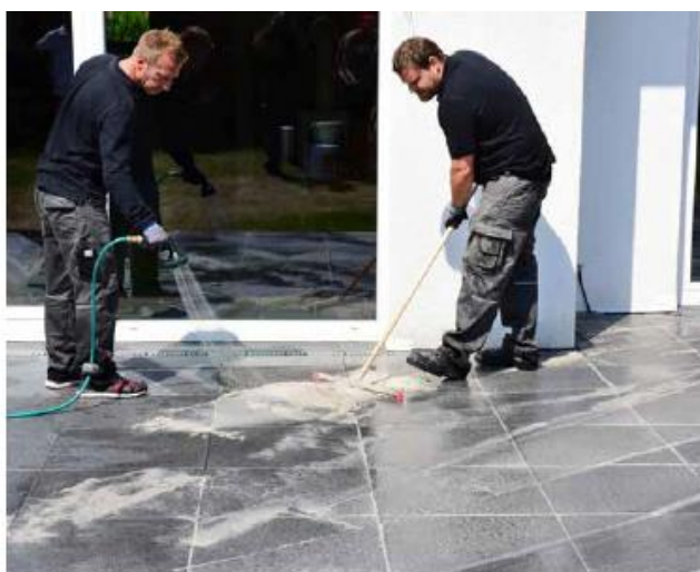
12 Змочіть матеріал струменем води до утворення пластичної консистенції....
