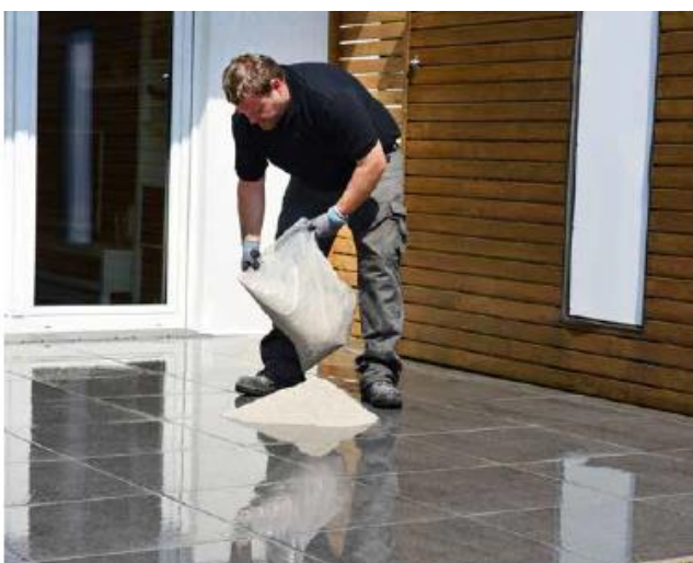
11 Нанесіть на облицювання затирку Sopro Solitär® F20.
