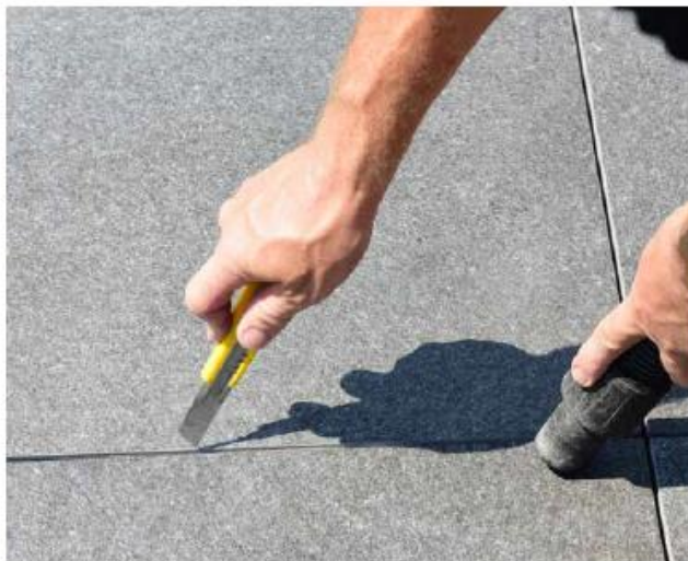
8 Ретельно очистіть шви та видаліть залишки суміші.
