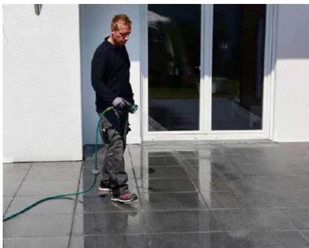
10 Перед затиркою ретельно змочіть поверхню облицювання і підтримуйте її у вологому стані.
