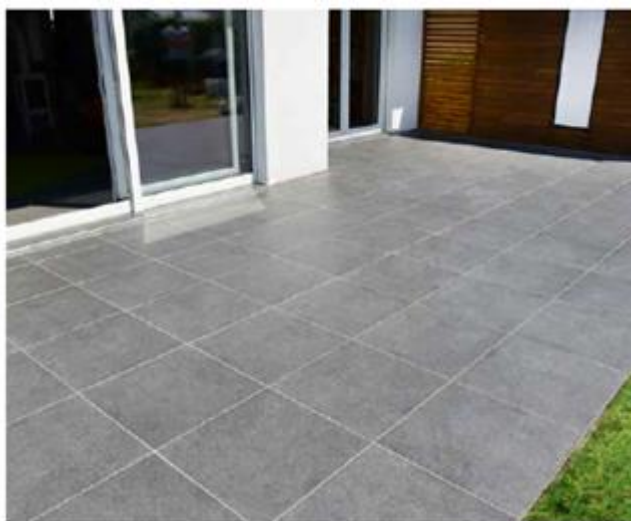
18 Затерта поверхня стає придатною для ходіння приблизно через 24 години.
